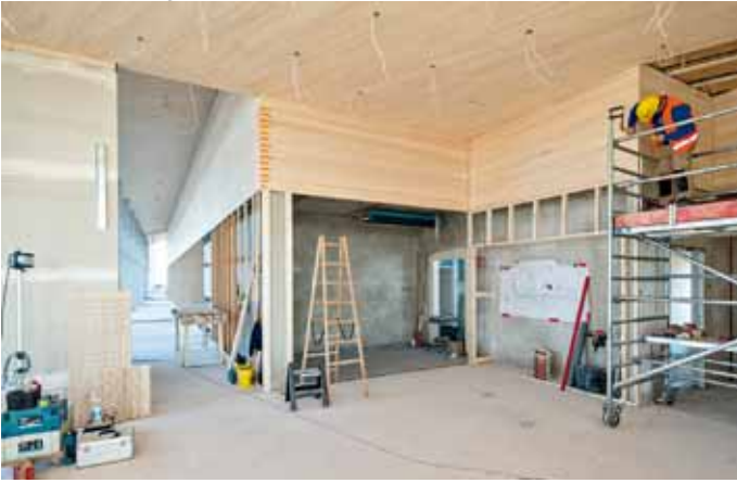
Der Holz-Innenausbau verkleidet den Stahlbetonkern.
