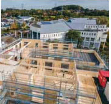
Montage der Wand- und Deckenscheiben. Links im Bild der Veranstaltungsraum im EG mit den Holz-Stahl-Sprengwerken. (Fotos: Johannes Buldmann / Züblin Timber)
