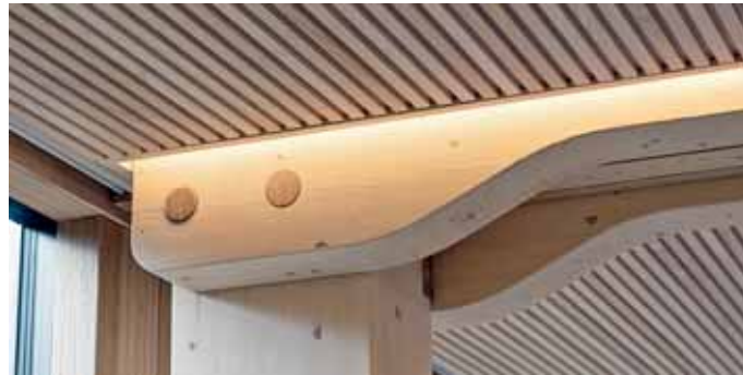
Baubuche-Dübel sind Verbindungsmittel dieser Stützen/Träger-Anschlüsse und gleichzeitig ein Gestaltungsmittel. (Foto: Sindre Ellingsen)
