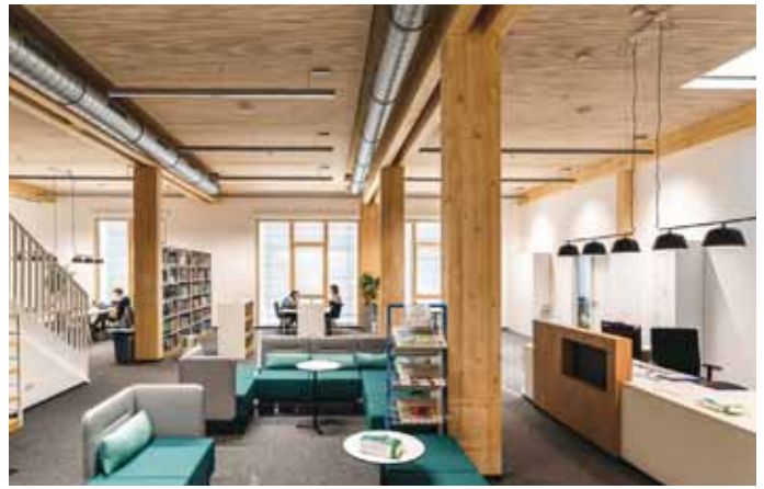
Während im Inneren ein Holzskelett das Tragwerk bildet, bilden Brettsperrholz-Elemente Decken, Dach und die Gebäudehülle aus. (Fotos: Johannes Buldmann)
