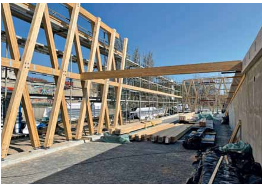
Unterzüge an rautenförmigen BSH-Stützen (Foto: Leitplan Architekten)
