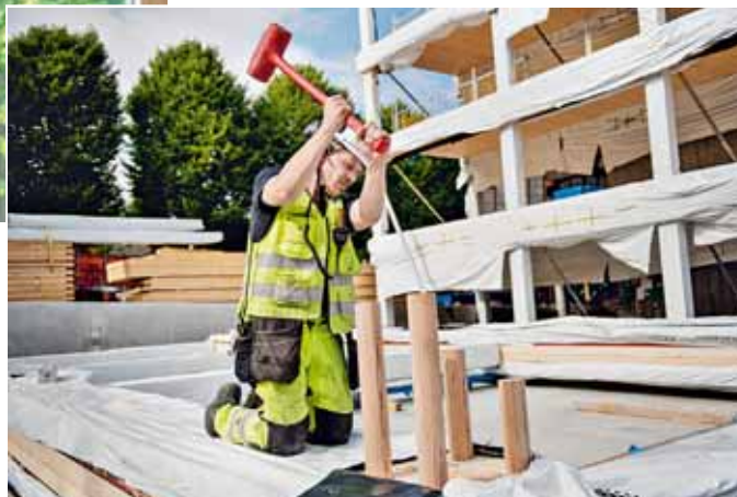
Baubuche-Dübel sind Verbindungsmittel dieser Stützen/Träger-Anschlüsse und gleichzeitig ein Gestaltungsmittel. (Foto: Sindre Ellingsen)
