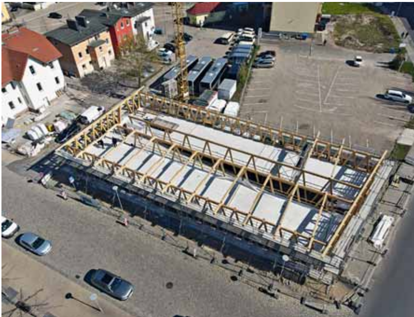
Montage der Deckenebene (Foto: Leitplan Architekten)
