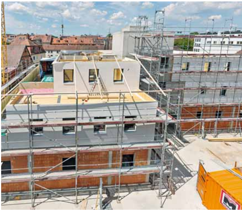
Montage der vorgefertigten Holzrahmenbau-Elemente auf der Baustelle
