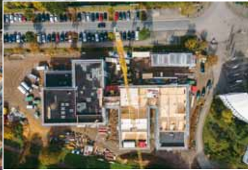
Montage der Wand- und Deckenscheiben. Links im Bild der Veranstaltungsraum im EG mit den Holz-Stahl-Sprengwerken. (Fotos: Johannes Buldmann / Züblin Timber)
