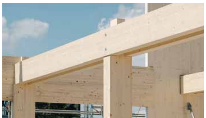
Unten; Die an den oberen Enden ausgeklinkten Stützen nehmen beidseitig die Brettschichtholz-Träger auf. Der überstehende „Restquerschnitt“ fädelt bei der Montage der Decken in entsprechende Aussparungen der Elemente ein. (Foto: Kaden+Lager)
