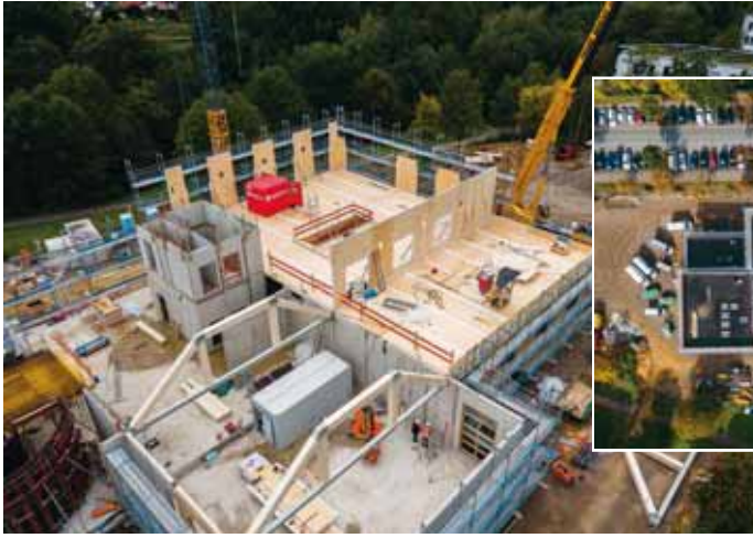
Deckengleiche Stahlunterzüge überspannen die gesamte Breite des Gebäudeblocks, vorbei an der Lichtschneise zwischen den beiden U-Schenkeln, zur Auflagerung der Deckenelemente.
