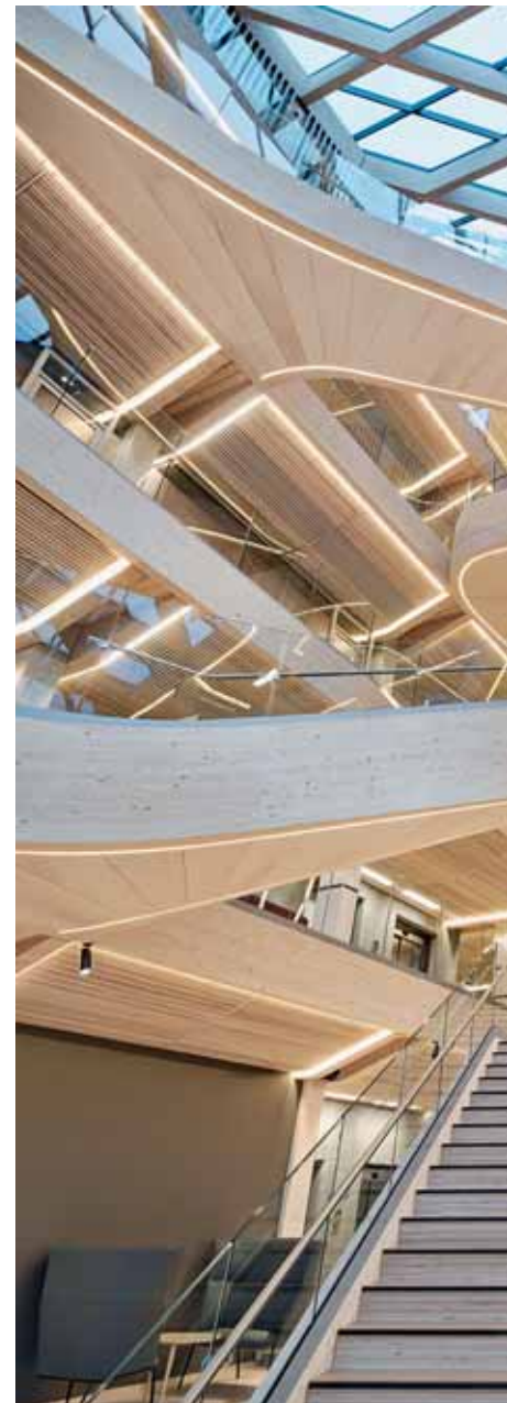
Baubuche-Dübel sind Verbindungsmittel dieser Stützen/Träger-Anschlüsse und gleichzeitig ein Gestaltungsmittel. (Foto: Sindre Ellingsen)
