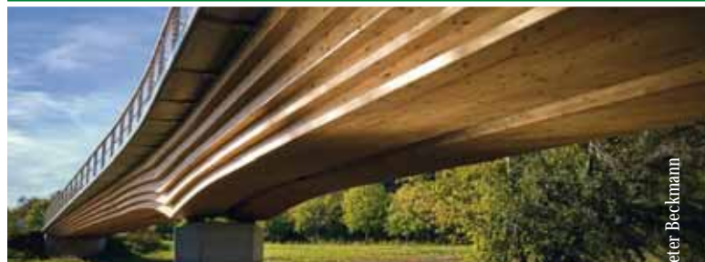
Fuß- und Radwegbrücke in Frankenberg (Eder)
