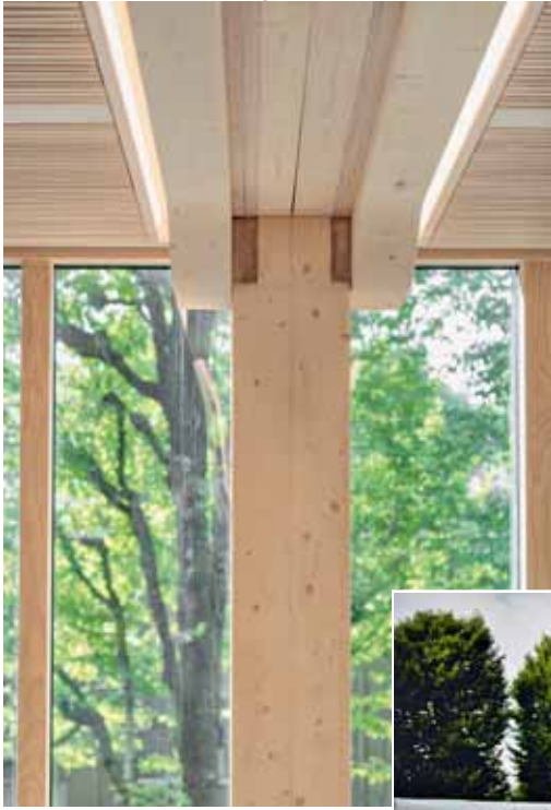
Gut sichtbar: die jeweils dreiteiligen Zangenträger mit Buchen-FSH-Einlegeplatten. (Foto: Sindre Ellingsen)
