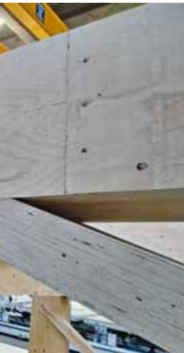
„Anschlussknoten“ von Ober- und Untergurt mit Treppenversatz, Schrauben und unterseitigem Auflagerklotz. (Fotos: Introgroup)
