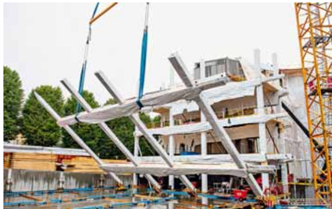
Stützen und Träger wurden achsweise zu Rahmentragwerken vormontiert und aufgerichtet. Die gebäudebreiten Träger nehmen die mehrgeschossigen Stützen „in die Zange“. (Foto: Jan Inge Haga)
