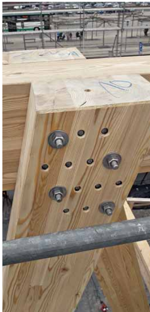
Typischer Tragwerks-BSH- Knotenpunkt (Foto: Zimmerei Thielke)
