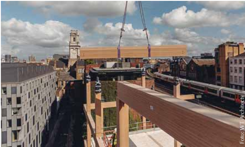
Eine hybride Struktur aus einem Buchen-LVL-Skelett mit Brettsperrholz-Scheiben und -Treppenhaukern erlaubt offene Arbeitsbereiche im Innern, ohne tragende Innenwände. (Foto: Waugh Thistleton Architects)
